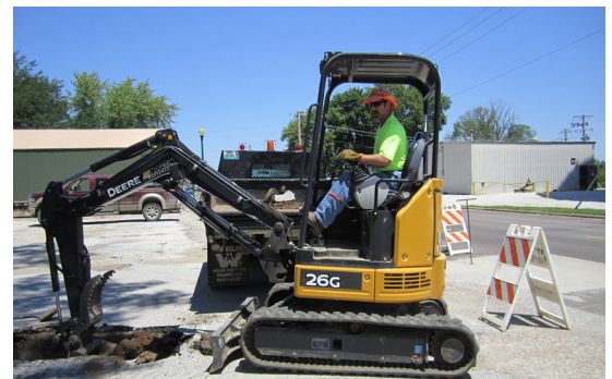
John Deere 26G Mini Excavator
